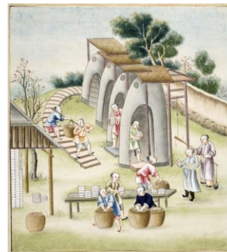
18 Ouverture des Fours
